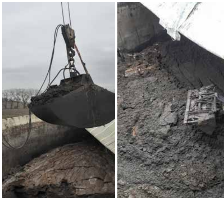
FOT. 1 Oczyszczenie fermentorów osadu sedymentacyjnego (źródło: materiały Goodvalley)
