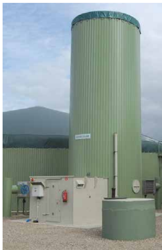
FOT. 4 Zewnętrzny biologiczny filtr odsiarczający (źródło: materiały Goodvalley)
