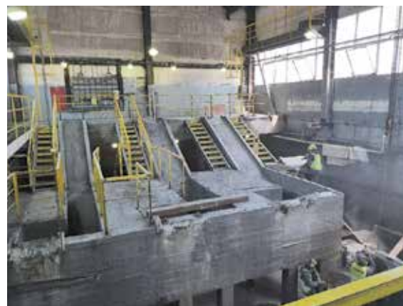
FOT. 5 W trakcie prac adaptacyjnych budynek pod oczyszczalnię w PEC – Gliwice
