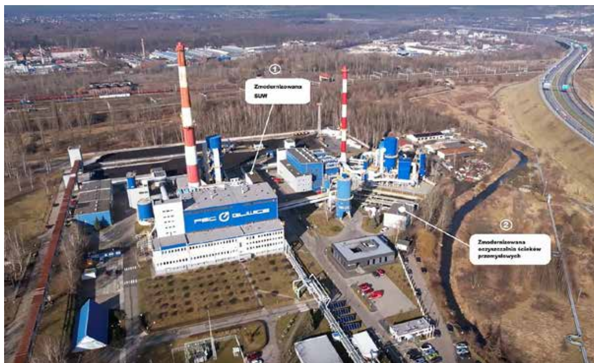
FOT. 2 Miejsca realizacji modernizacji gospodarki wodno-ściekowej w PEC – Gliwice
