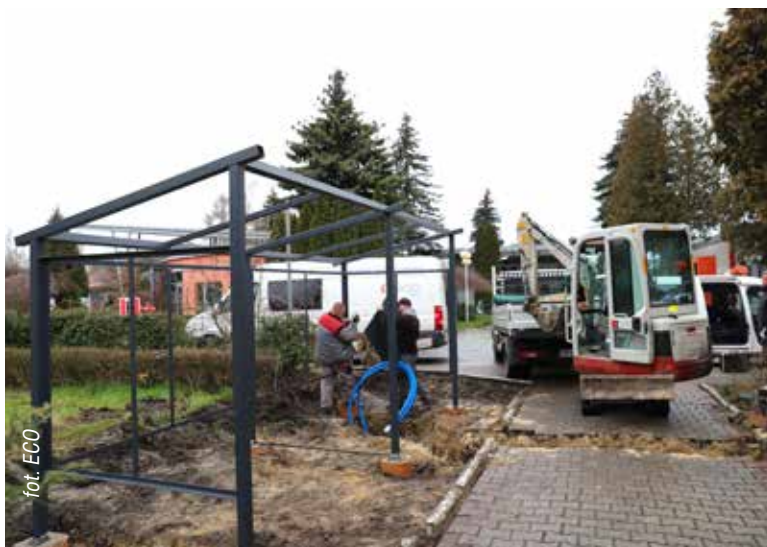
FOTOWOLTAICZNA WIATA ROWEROWA w budowie
