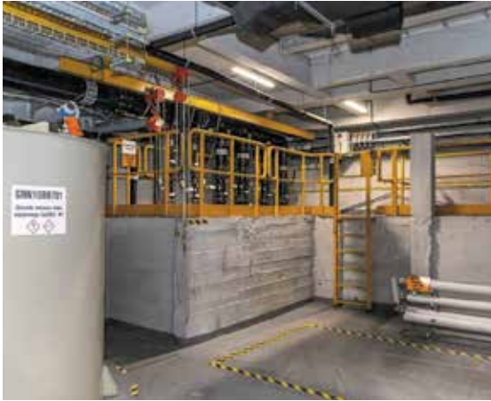
FOT. 6 Oczyszczalnia ścieków po modernizacji
