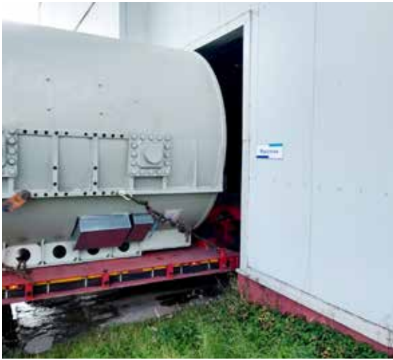
Transport beczki generatora po wykonanym remoncie (wjazd na maszynownię)
