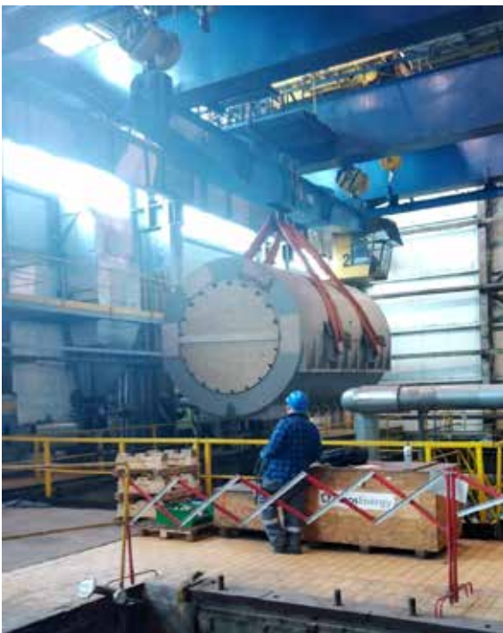
Transport na stanowisko na poziom TG2
