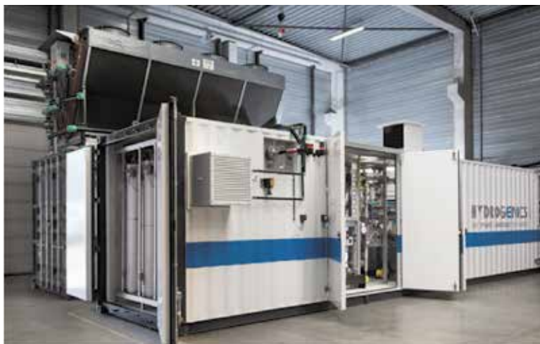
FOT. 1 Elektrolizer firmy Hydrogenics – HyLAZER – wygląd zewnętrzny
