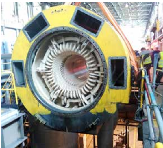
Moment opuszczania stojana na poziom -3,5 m, załadunek na nacepę
